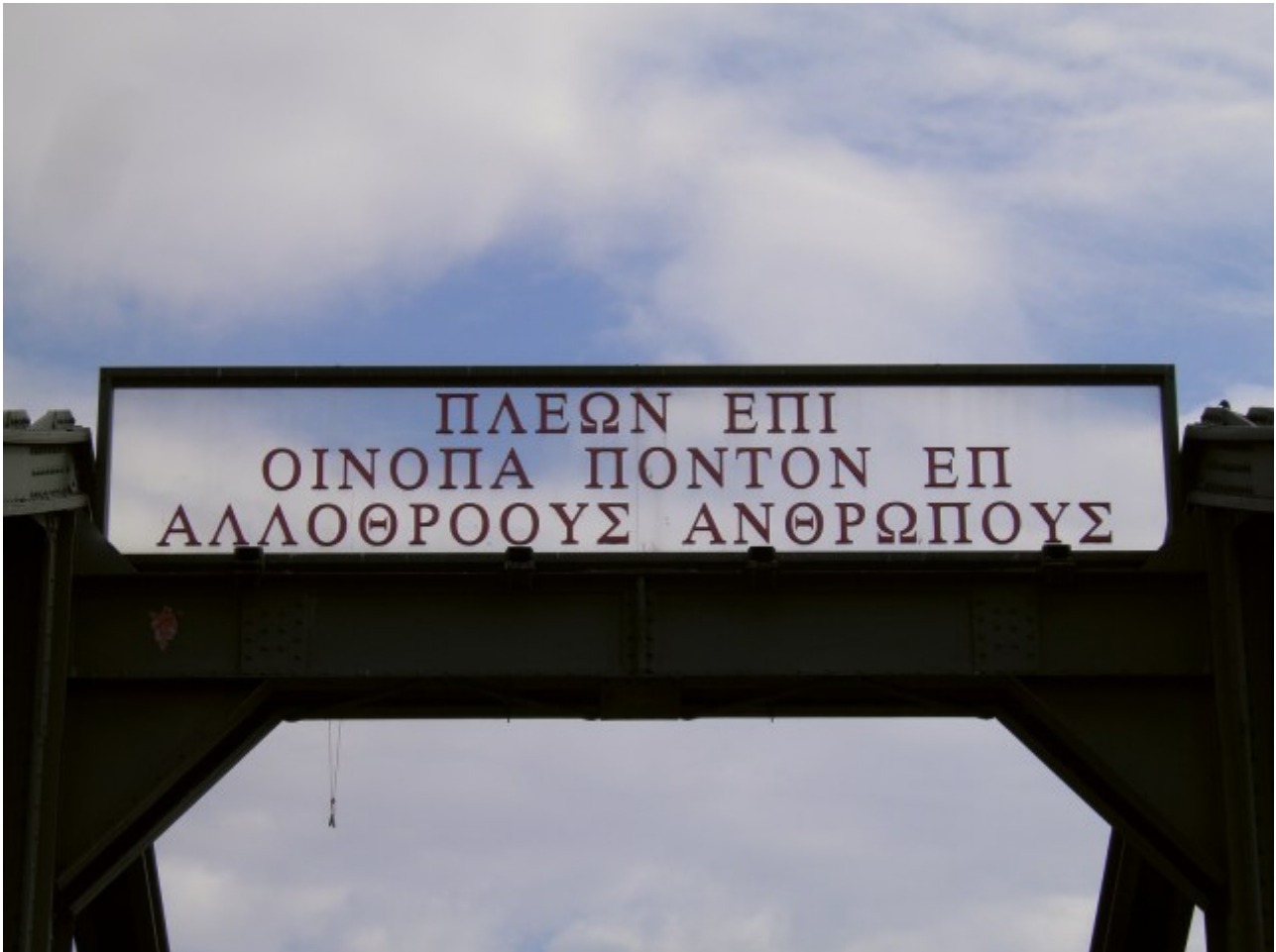
Eiserner Steg, Frankfurt am Main
