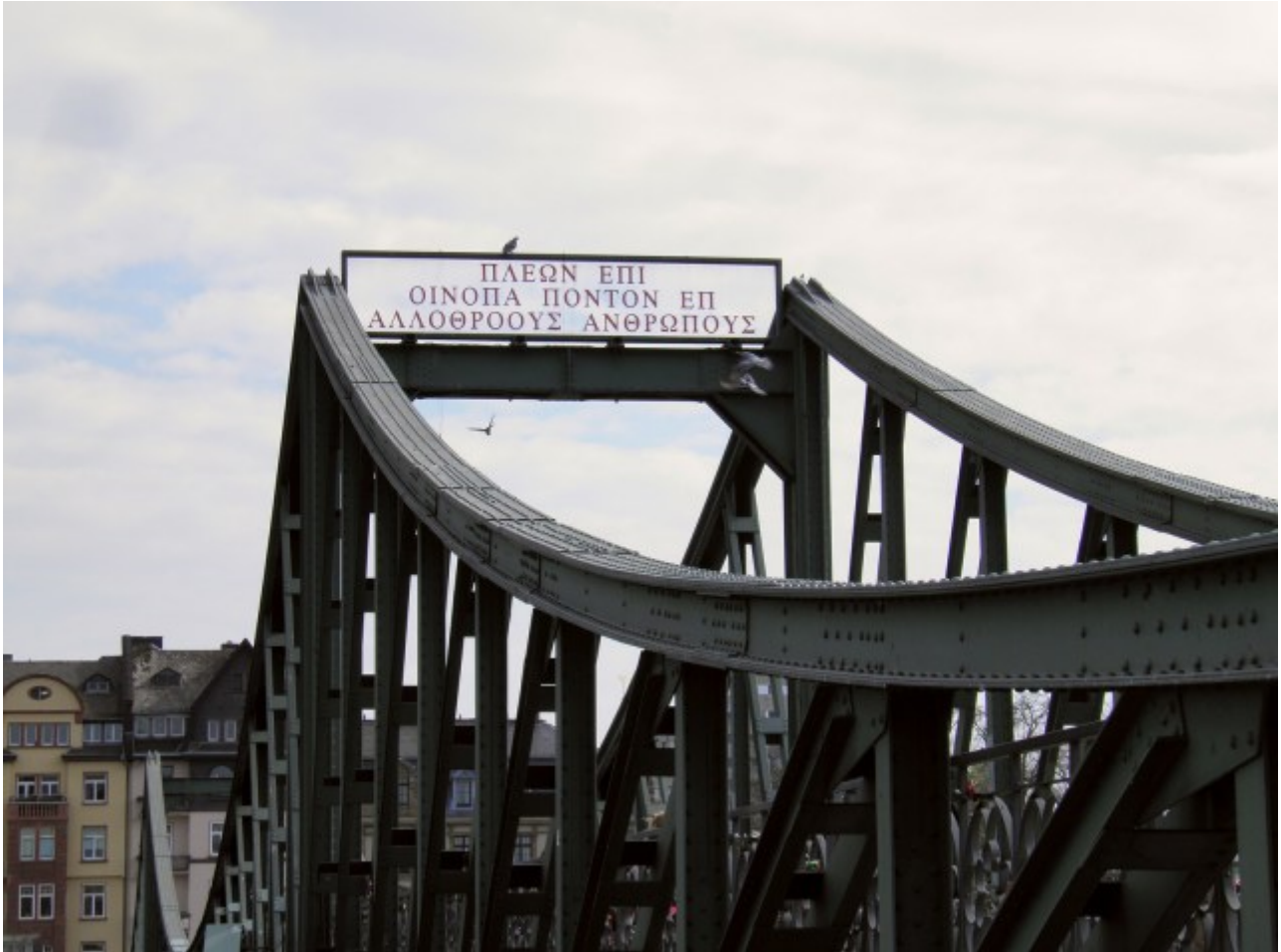
Eiserner Steg, Frankfurt am Main
