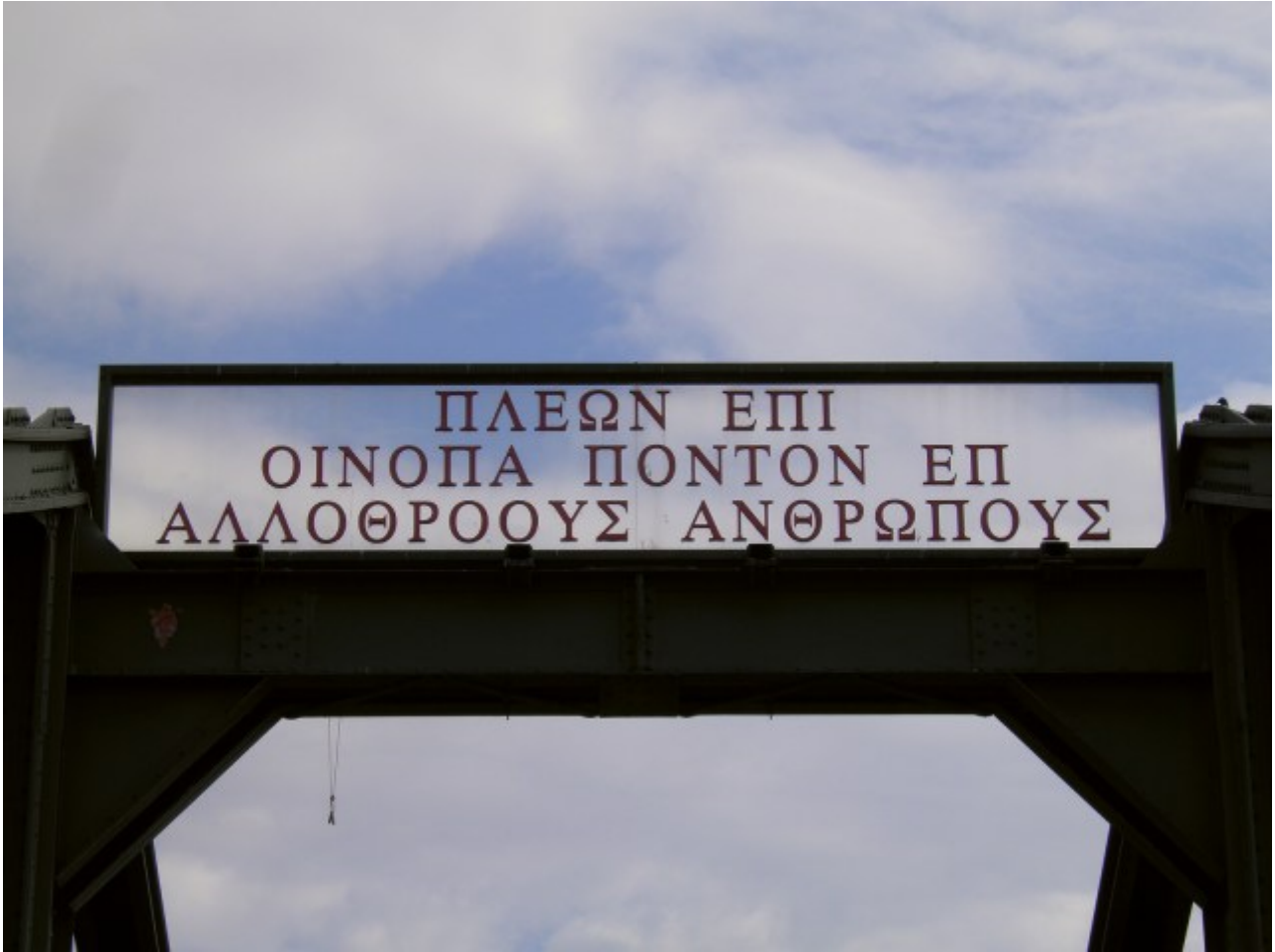
Eiserner Steg, Frankfurt am Main
